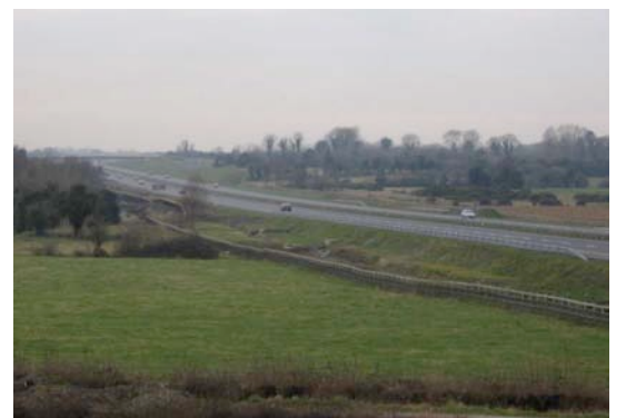
New M4 road corridor
