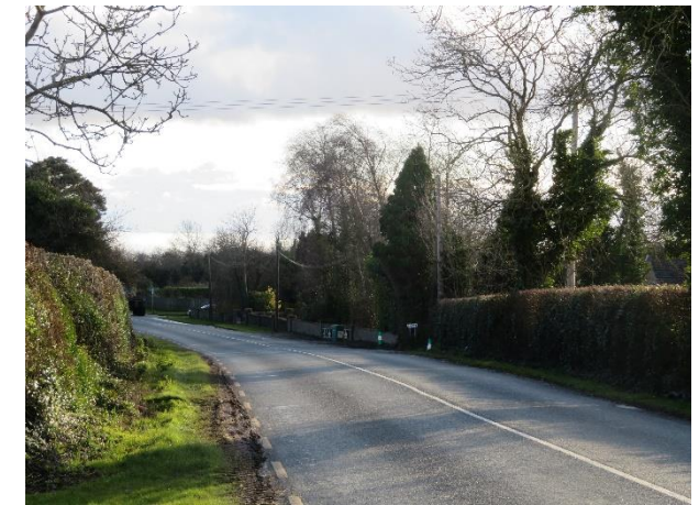
Commons Lane Junction
